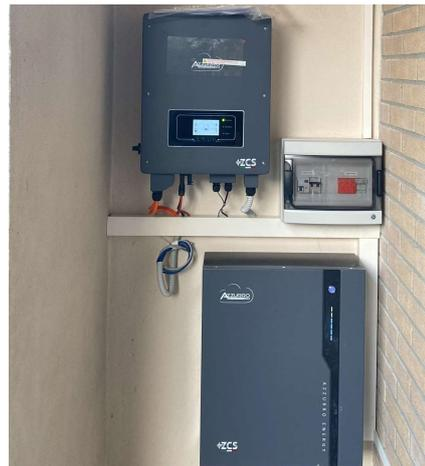
**Realizzazione impianto fotovoltaico da 10 kW
